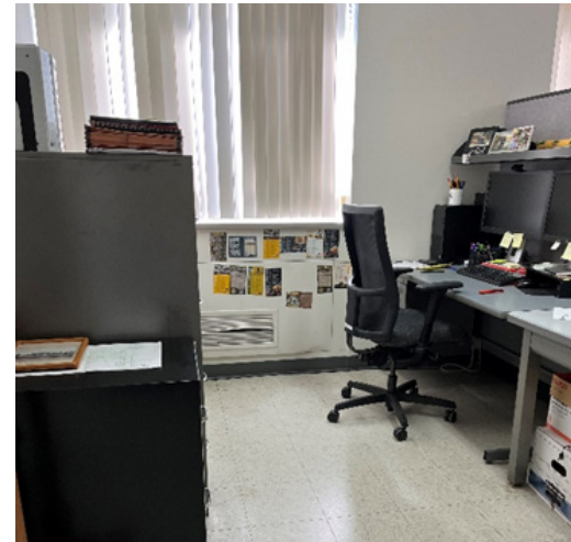
Bent louver blades
