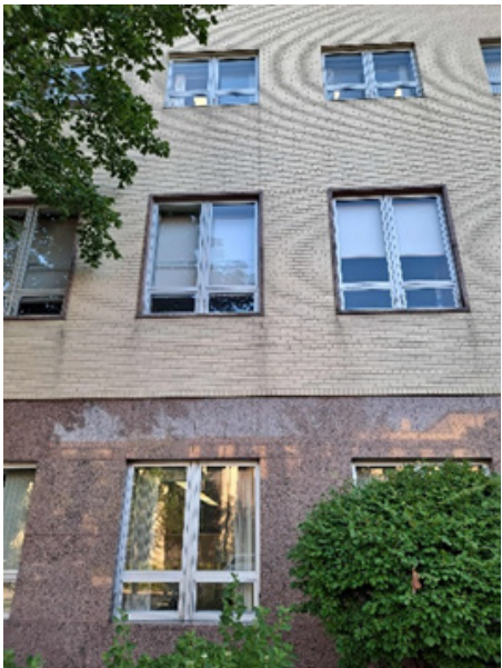
Replace exterior windows
