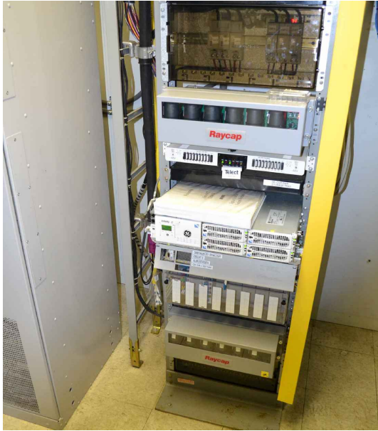
A EXISTING RAYCAP JUNCTION BOX IN SHELTER SCALE: N.T.S.
