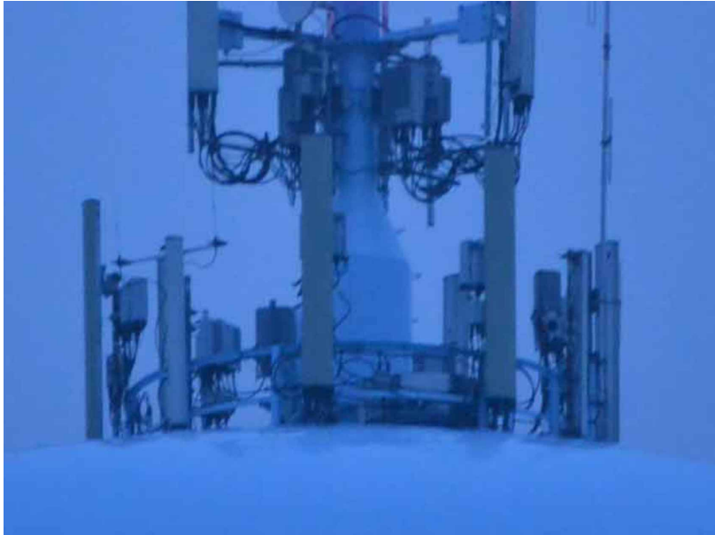
2 PHOTO OF ANTENNA LEVEL SCALE: N.T.S.
