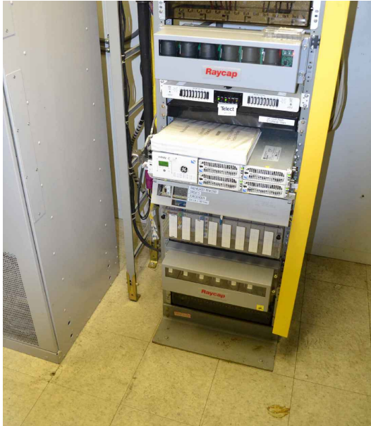
3 EXISTING RAYCAP JUNCTION BOX IN SHELTER SCALE: N.T.S.
